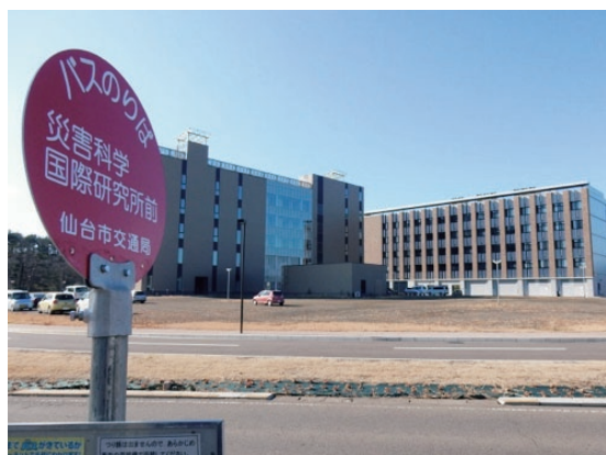
旧ゴルフ場跡地に立つ災害科学国際研究所
